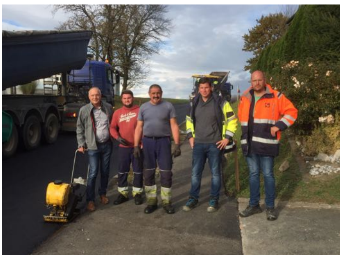
Die Bauarbeiten schritten zügig voran, wovon sich Bürgermeister Wolfgang Sodl vor Ort überzeugen konnte.
